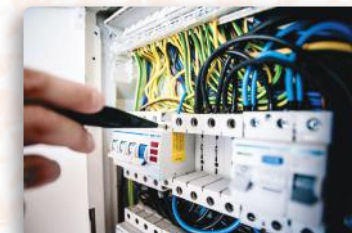
Montagem de Sistemas Elétricos
