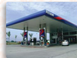
Montagem de Instalações Elétricas em Áreas Classificadas "À Prova de Explosão"
