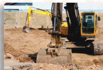
Preparação de Canteiros de Obras
