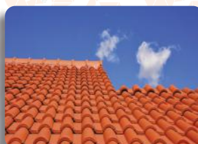
Construção e Reforma de Telhados
